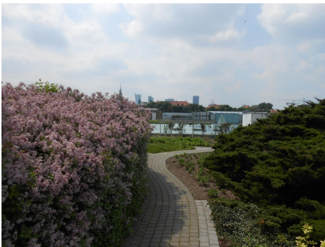
Dach zielony (ogród na dachu) na budynku Biblioteki UW w Warszawie. Przykład dachu o zazielenieniu intensywnym.
