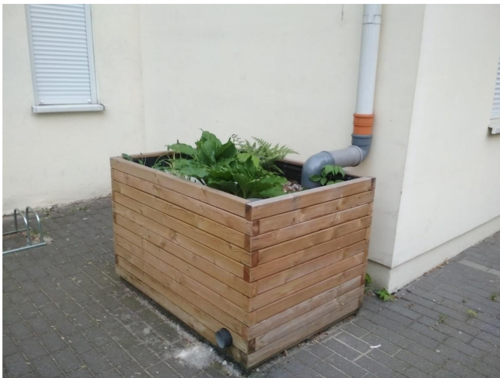
Ogród deszczowy w pojemniku przy budynku szkoły podstawowej w Warszawie. Opóźnia odpływ wody opadowej i odciąża miejską sieć kanalizacji deszczowej.
