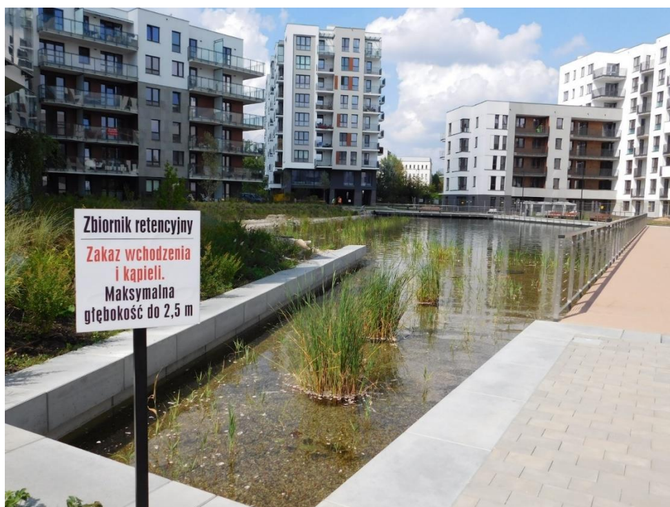
Zbiornik retencyjny na terenie osiedla mieszkaniowego w Warszawie. Stanowi istotny element systemu zagospodarowania wody opadowej wraz z zielonym dachem i zbiornikami retencyjnymi podziemnymi. Za jakość wody w zbiorniku odpowiada roślinna strefa regeneracyjna oraz filtry mineralne.
